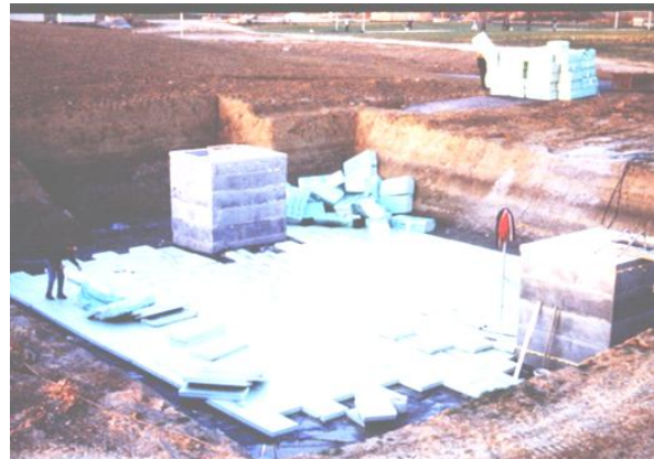
Bild 4: Einbau der XPS-Wärmedämmung auf regennasser Abdichtbahn (KDB), Erdsonden-Wärmespeicher in Neckarsulm, (1. Ausbaustufe) (Quelle: ITW)
