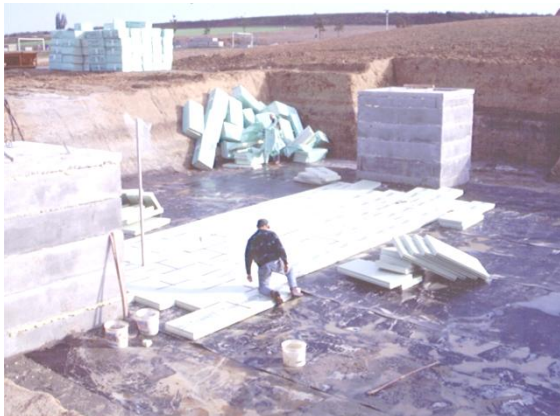
Bild 4: Einbau der XPS-Wärmedämmung auf regennasser Abdichtbahn (KDB), Erdsonden-Wärmespeicher in Neckarsulm, (1. Ausbaustufe) (Quelle: ITW)
