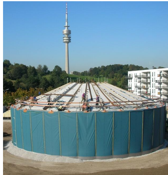
Bild 4: Blähglasgranulat in Membran-Schalung, Außenlaborversuche am ITW (Quelle ITW) und Projekt SNAB, München-Ackermannbogen (Quelle Solites)
