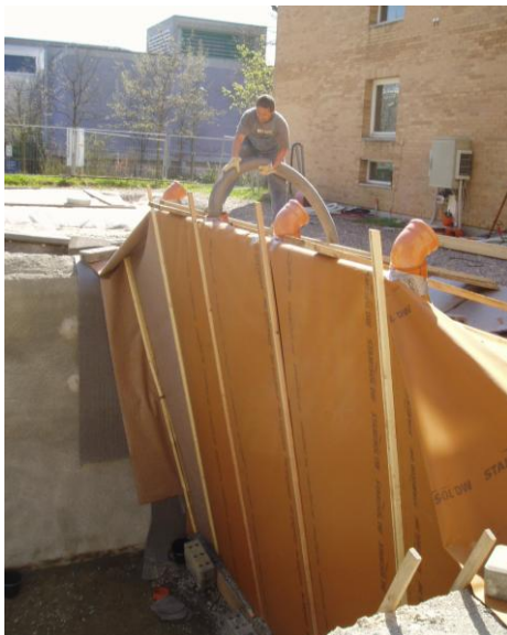
Bild 4: Blähglasgranulat in Membran-Schalung, Außenlaborversuche am ITW (Quelle ITW) und Projekt SNAB, München-Ackermannbogen (Quelle Solites)
