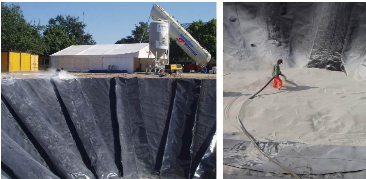
Bild 4: Einbringen der Wärmedämmung in HDPE-Sperrschichtbahn-Kammern sowie der Bodendämmung durch Einblasen aus dem Silo-LKW (Kies-Wasser-Wärmespeicher in Eggenstein, Quelle: ITW)
