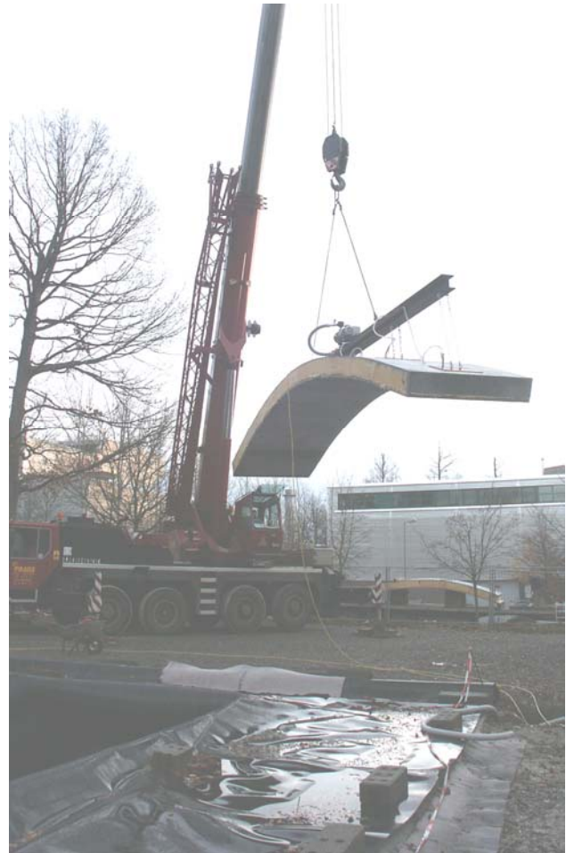
Bild 5: Autokran beim Heben eines Sandwichelements mittels Vakuumhebezeug
