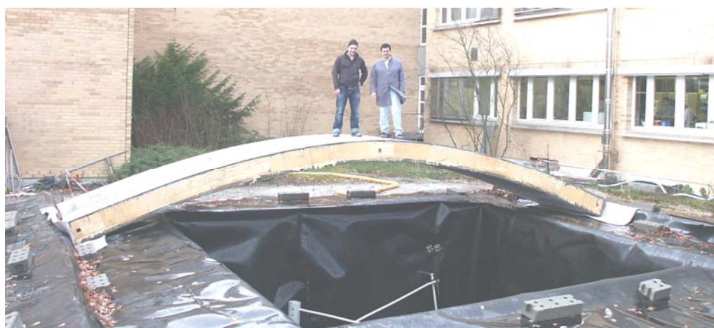
Bild 4: Montage des 1. Fertigteils auf dem Außenlabor Heißwasser-Erdbecken-Wärmespeicher am ITW
