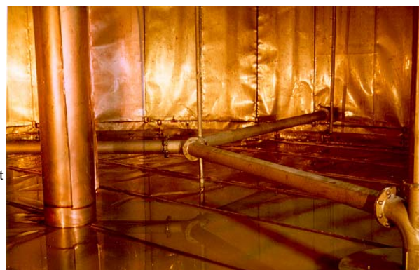
Bild 4: Wandaufbau und Innenauskleidung (Projekt Rottweil [6])
