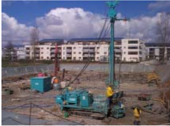
Bild 8: Blick auf die Baugrube (2. Speicherausbau)
