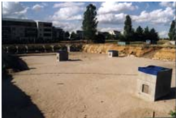
Bild 10: Erdsonden-Wärmespeicher vor der Verfüllung
