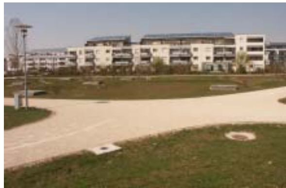
Bild 11: Blick auf den Erdsonden-Wärmespeicher nach der Landschaftsgestaltung
