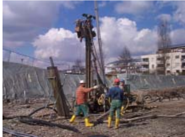
Bild 9: Installation der Erdwärmesonden
