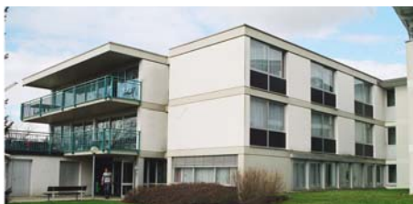
Bild 2: Südansicht eines Gebäudes von ~1970
