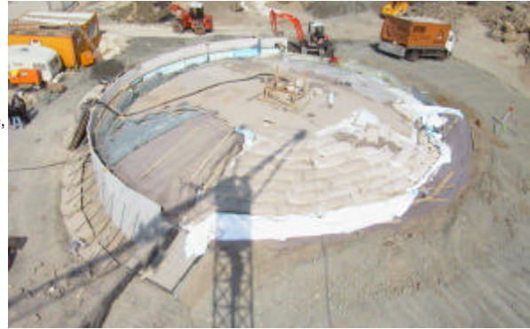
Bild 11: Wandaufbau und Speicher im Bau (Projekt Hannover-Kronsberg)
